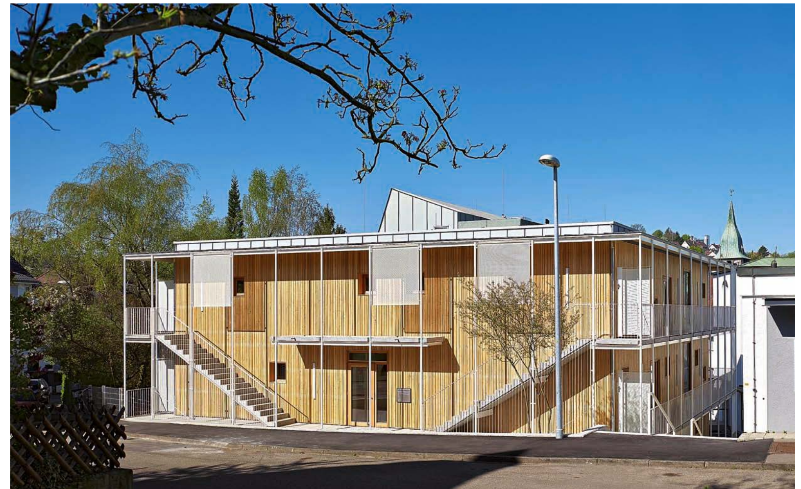
Fassade Eingangsseite mit Erschließung der umlaufenden Balkone der Obergeschosse
